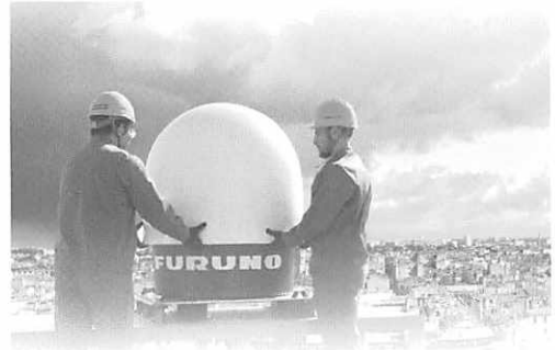
「型式：WR110」のアンテナ設置作業イメージ
